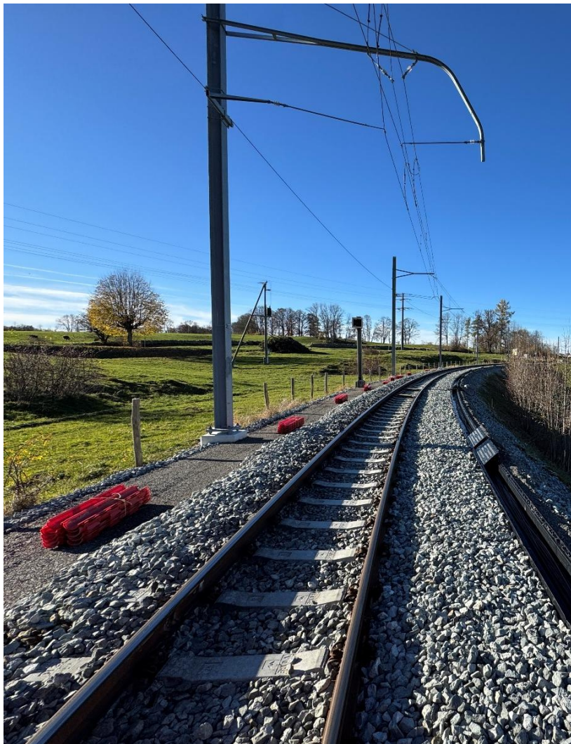
Voie ferrée, Forêt des Peux
