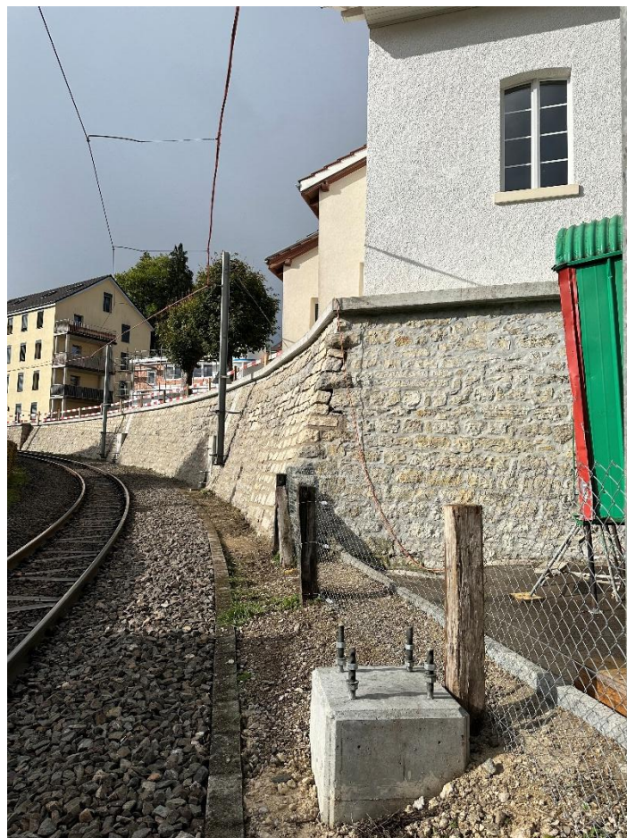
Mur de protection, Tramelan
