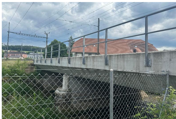
Pont sur l'Allaine, Porrentruy
