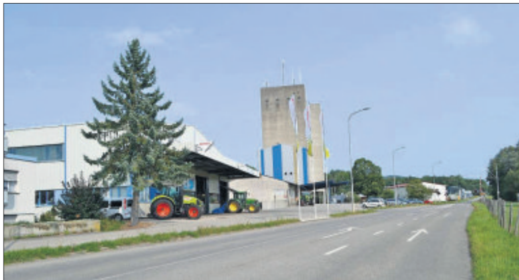
Le site Landi ArcJura accueillera la future plateforme de transbordement rail-route d'ici 2021.
