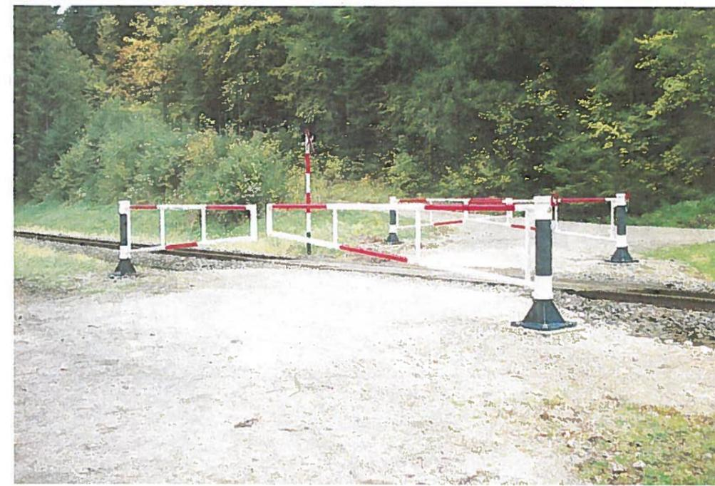
Un exemple d'assainissement de passage à niveau sur le réseau des Chemins de fer du Jura, sur la ligne entre Tavannes et Tramelan. A gauche, la situation avant les travaux, sans barrières. A droite, la situation nouvelle, avec barrières et réaménagement du chemin, qui oblige ses usagers à ralentir avant de s'engager sur le passage. SP-CHEMINS DE FER DU JURA
